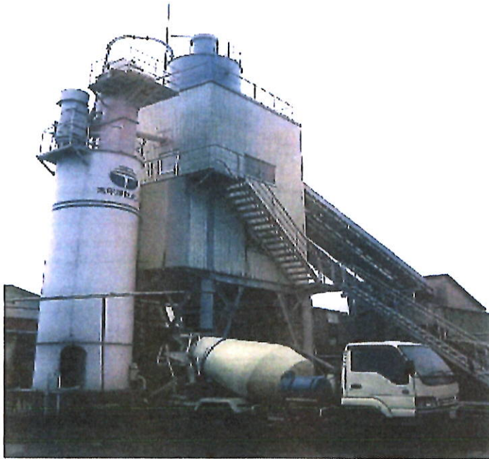
生コンプラント写真
