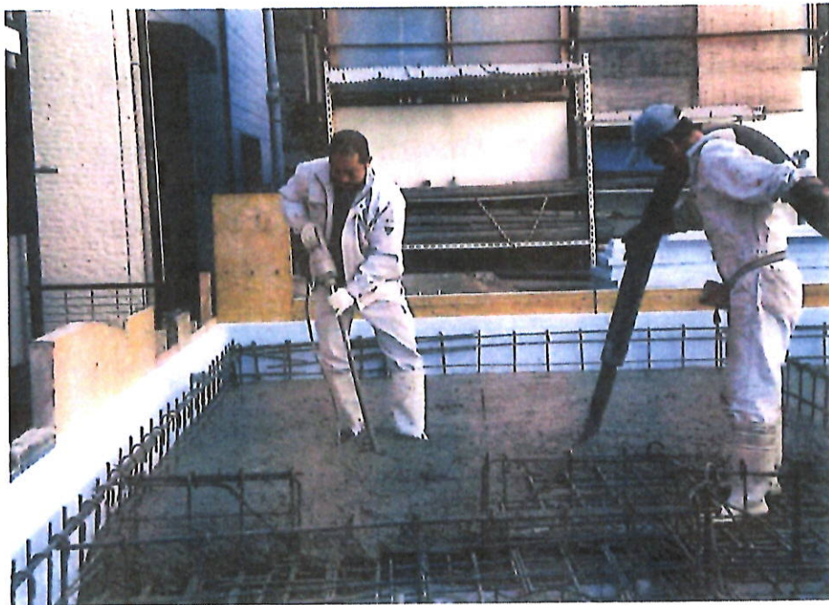
生コン打設作業写真
